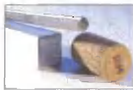
С левой стороны экран упирается в алюминиевый уголок, привинченный к стене. Шпильку для фиксации экрана заворачивают в резьбовое отверстие в уголке, ее надо законтрить гайкой
