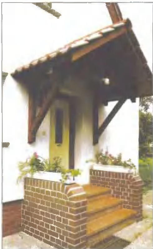
Двускатная черепичная крыша опирается на прикрепленные к стене консоли
