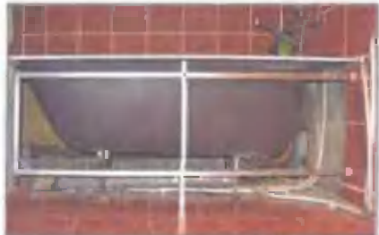
Внешний вид готового каркаса
