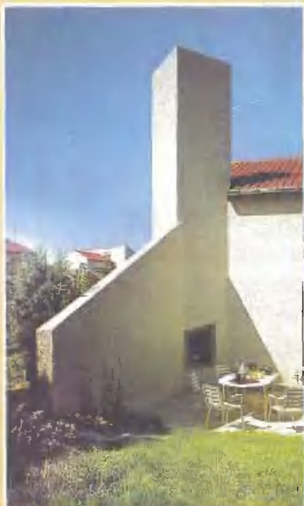
От палящих лучей солнца терраса укрыта небольшой стенкой в форме трапеции. К высокому угловому камину снаружи пристроено простое барбекю из огнеупорного кирпича
