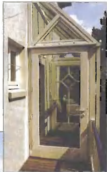
Светопрзрачный купол этого тамбура сооружен с применением небьющегося стекла
