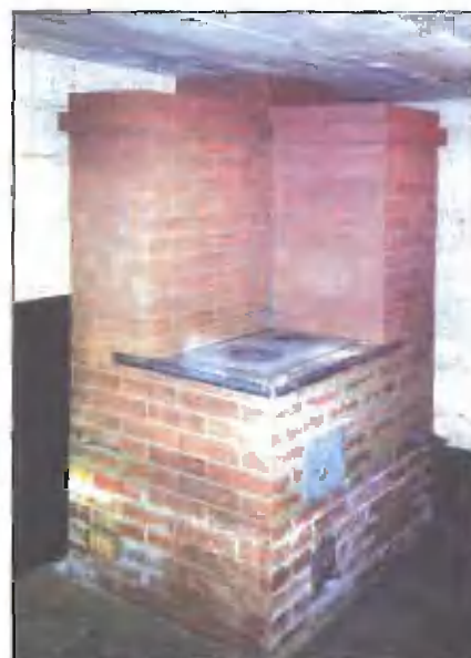
Завершающий этап строительства. После того, как печь очистят от глины и высушат, она будет готова к эксплуатации
