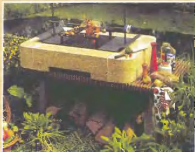
На очаге из гофрированной черепицы установлен цоколь из ракушечника, в который заделана решетка для жарки с двумя рогульками для вертела
