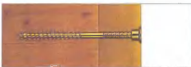
Вверните шуруп до упора
