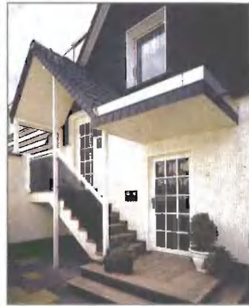
Интересное решение — объединение двускатной и плоской крыш подчеркивает расположение входных дверей на разных уровнях
