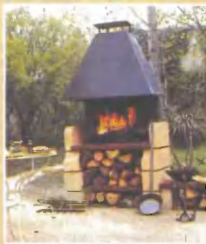
На стойках-столбиках из Гардского камня оборудован очаг из красного огнеупорного кирпича. Над очагом - навес из черного металлического листа
