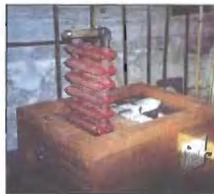
Водогрейный котел — главная деталь этой печи
