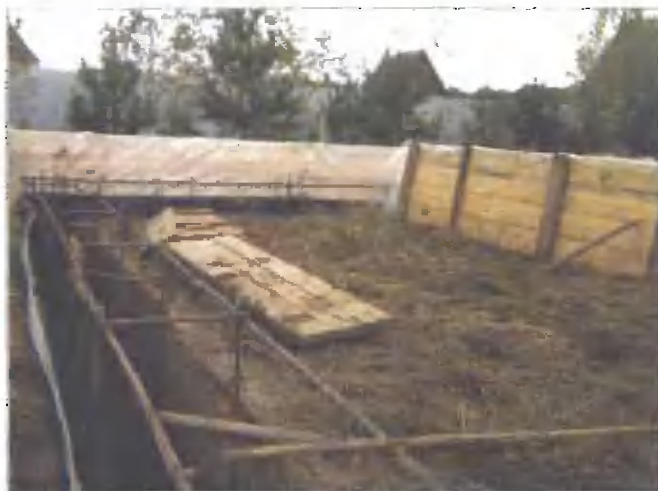
Изготовление щелевого фундамента
